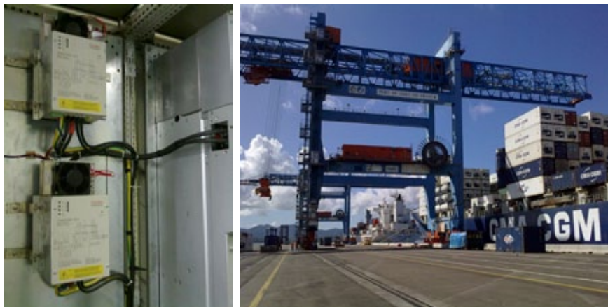
Applikationsbeispiel Antriebssteuerung für Krananlage. Parallel geschaltete Brems-Chopper erhöhen die Bremsleistung des Antriebsumrichters. Brems-Chopper verfügbar von 6 kW bis 1.200 kW.
