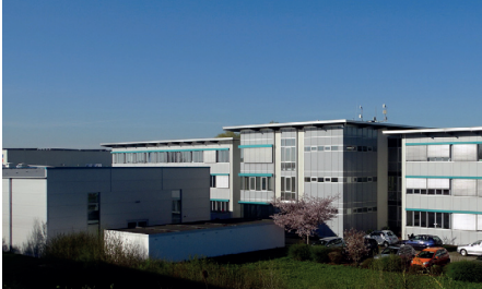
Gebäudeansicht Technologie Centrum Westbayern und Robotikhalle
